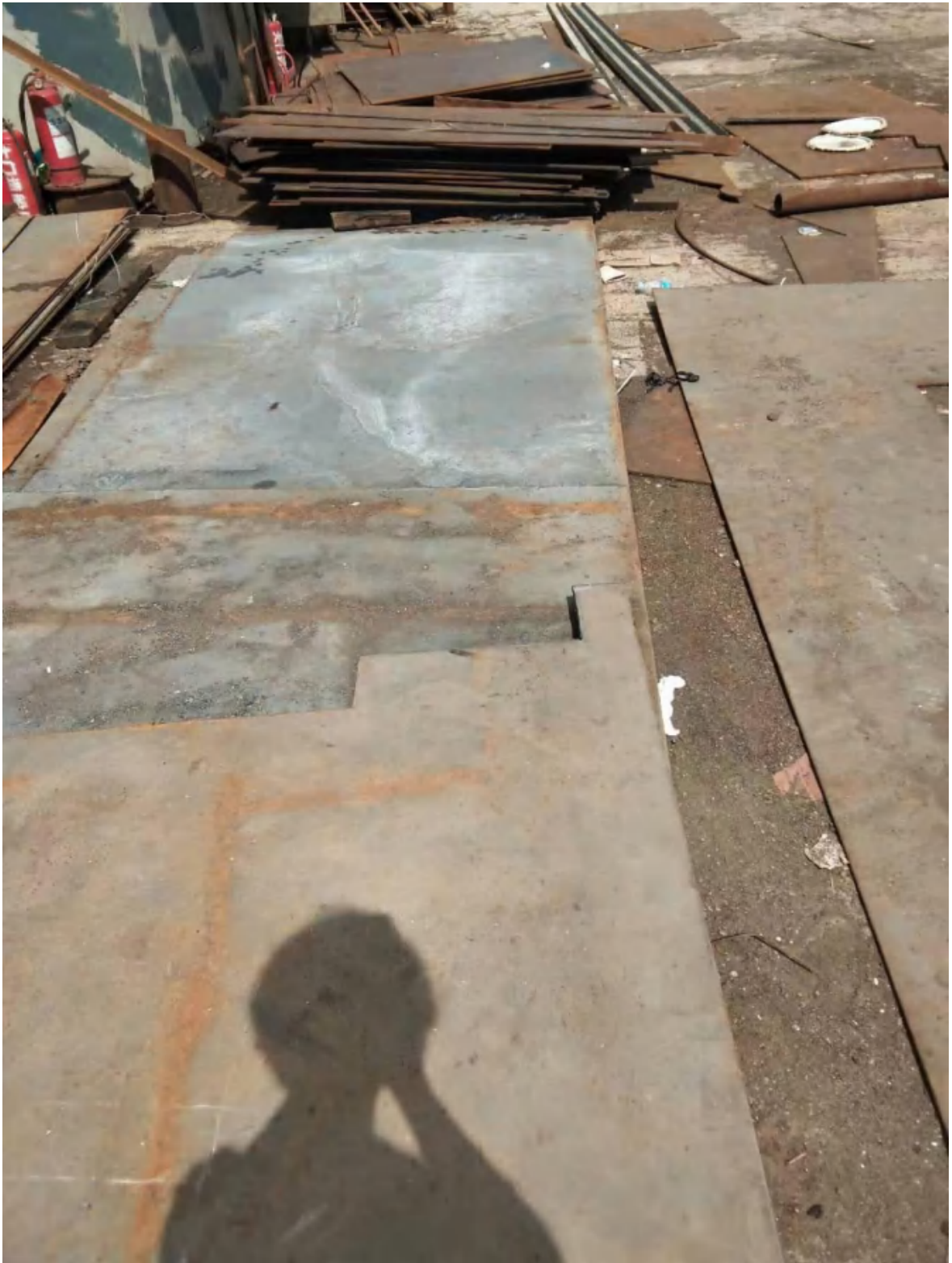
一般固废堆场
